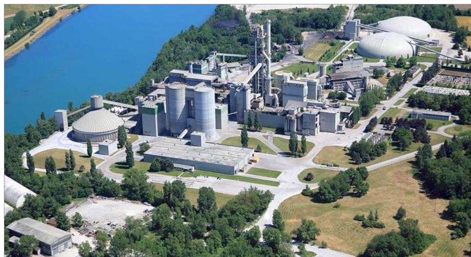
Pour chauffer ses installations, le fabricant de ciment utilise des pneus usagés. Photo D.GRANDEMANGE
